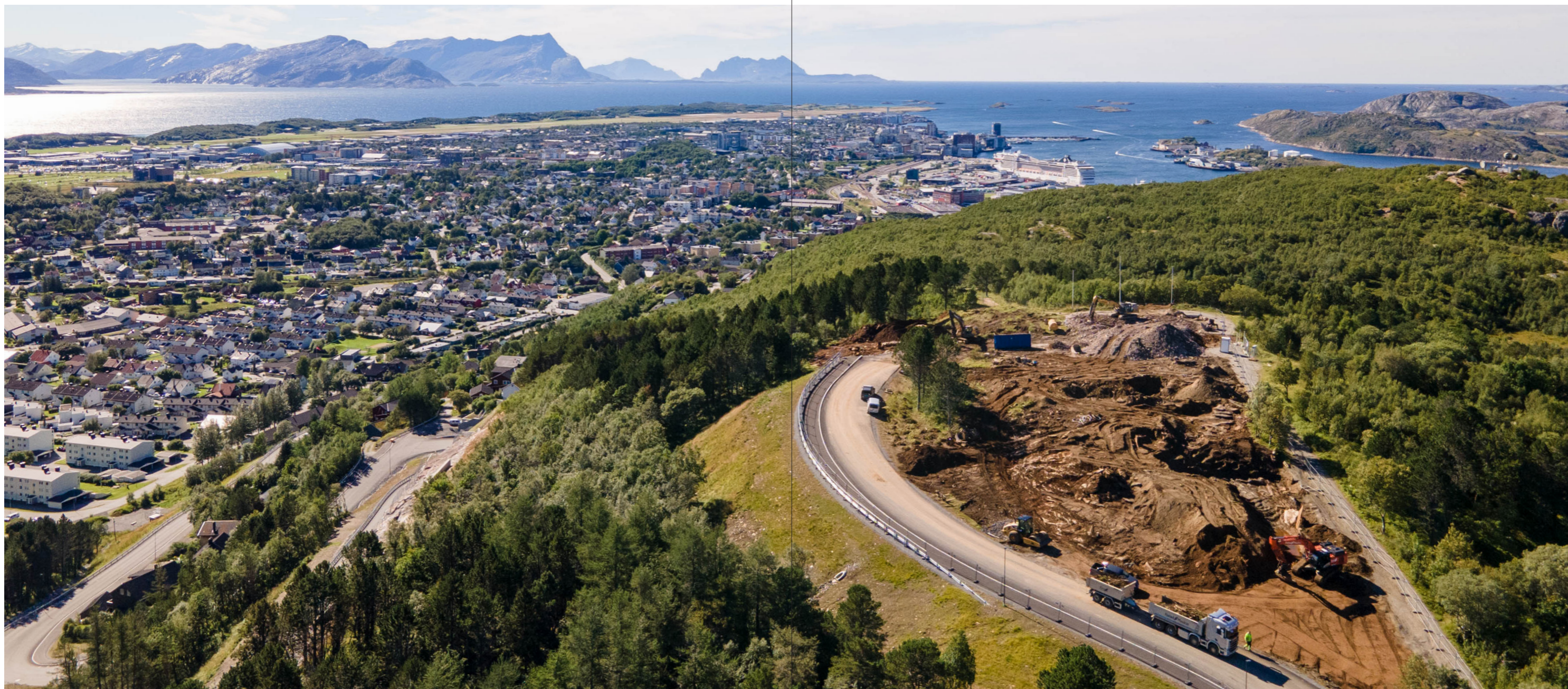
Foto: Utgraving av tomt på toppen av Rønvikfjellet i Bodø. Her åpner prosjekt Wood Hotel Bodø i 2024.
