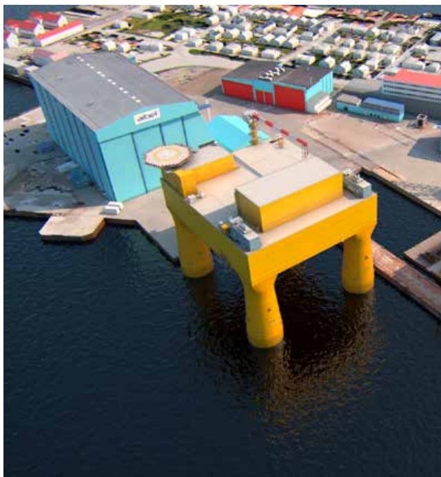
Aibel. DolWin 5, ett projekt för kraftöverföring från vindkraftsparker i Östersjön till tyska fastlandet, ska färdigställas till år 2024.
